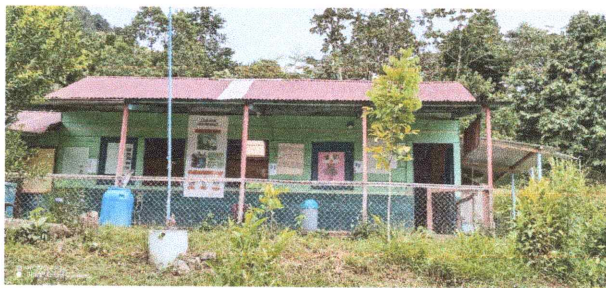
Foto 5: cambio de laminas con goteras
