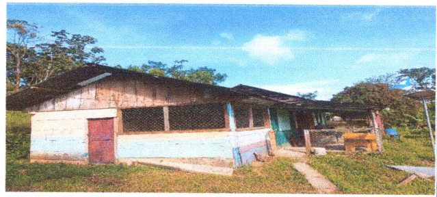
Foto 4: Sustitución de balcones de madera a metal.
