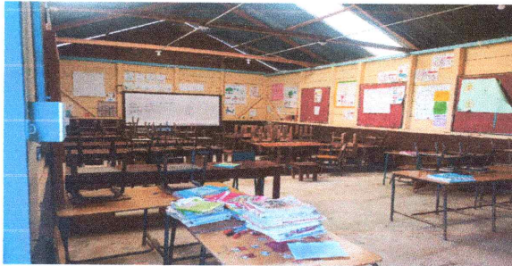
Foto 3: Sustitucion de laminas, bigas y tijeras en aula.
